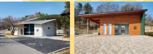
左／自由広場のトイレ。右／噴水広場のトイレ。
