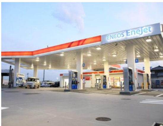
ガソリンスタンド再生改造工事
