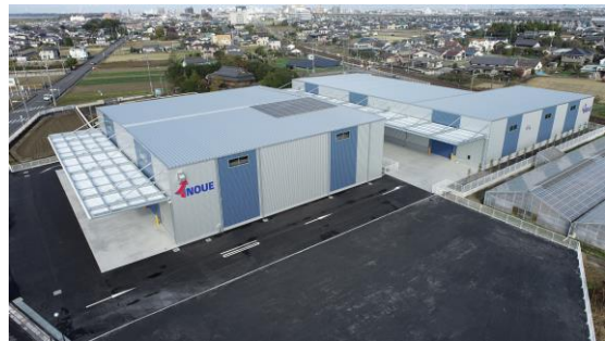
物流倉庫建設工事
