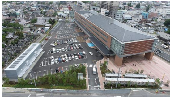
深谷市役所建設工事
