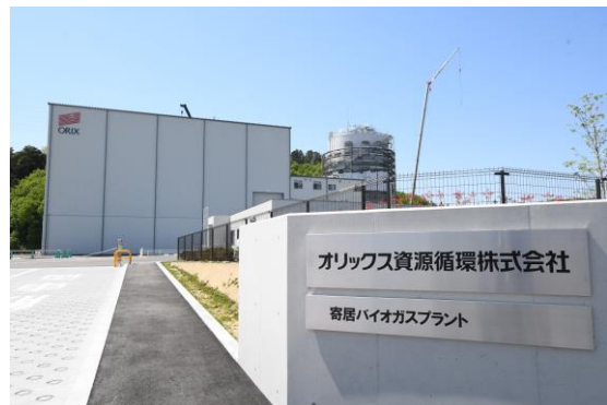
バイオマス発電プラント建屋建設工事
