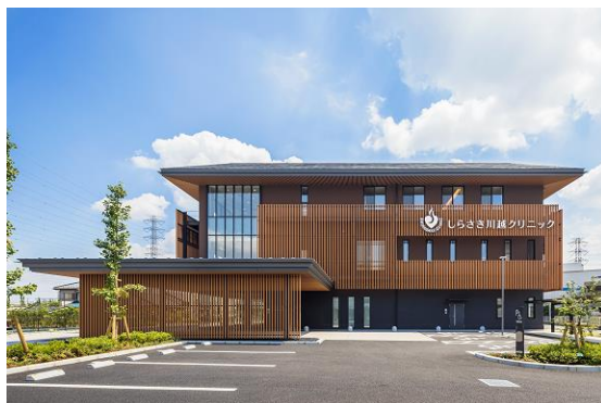
クリニック建設工事
