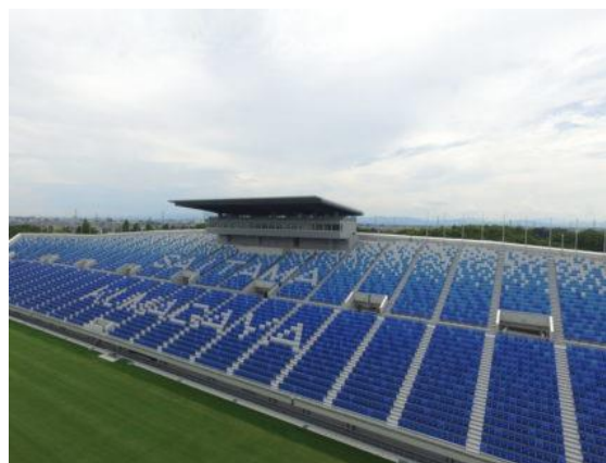
スタジアム外部改修工事
