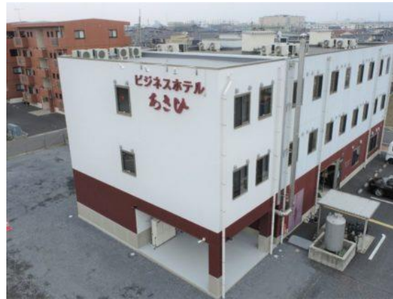
ホテル増築工事
